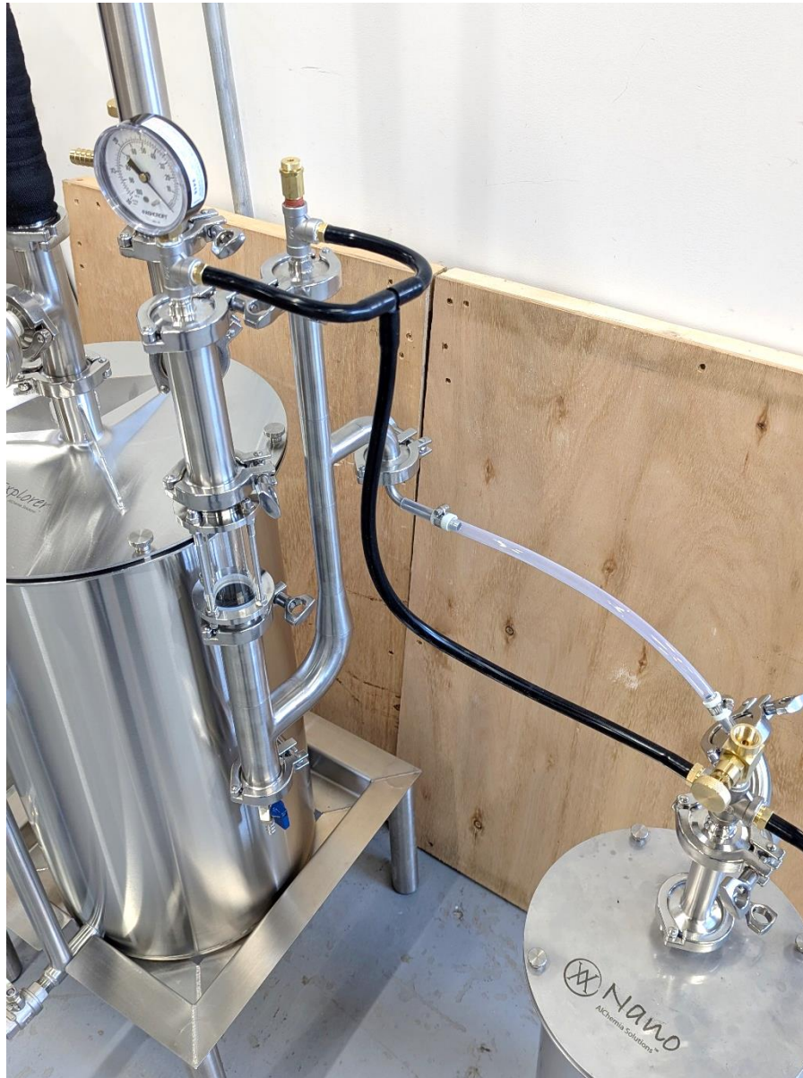
Photo 10 : Raccordement des tuyaux à vide.
